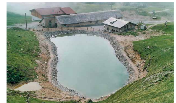
Seit 2000 schneesicher: Das Skigebiet Tschierg spiest seine Beschneigungsanlagen aus dem 2700 m 2 grossen Becken auf dem Ofenpass.
