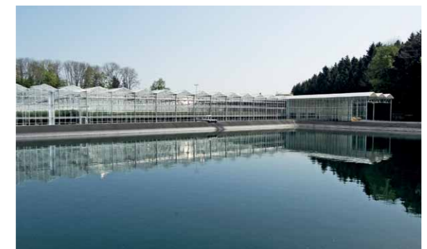
Regenwasserbecken zur Bewässerung einer Tomatenplantage.
