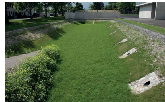
Kehrichtverbrennungsanlage Thun: Innert drei Tagen nach Bestelleingang war das Retentionsbecken abgedichtet.
